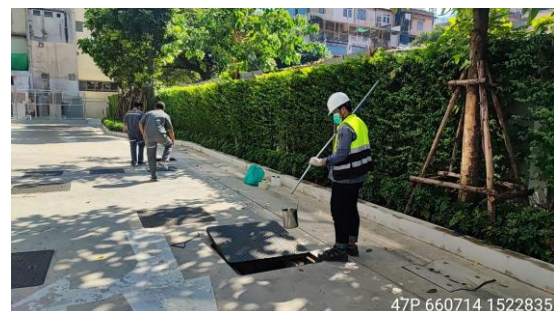
บริเวณหลังออกจากระบบบำบัดน้ำเสีย- บ่อตรวจคุณภาพน้ำ ชุดที่ 2
